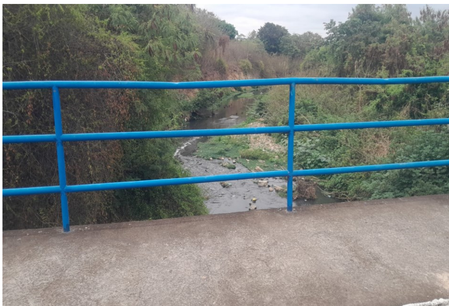
Foto 2 – Rio Formiga sob a ponte localizada na rua Alexandre Tavares do Couto
