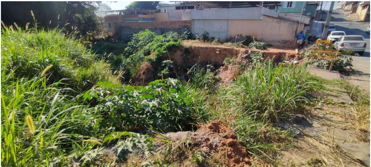
Foto 4 – Exposição de estacas de madeira nos blocos de fundação
