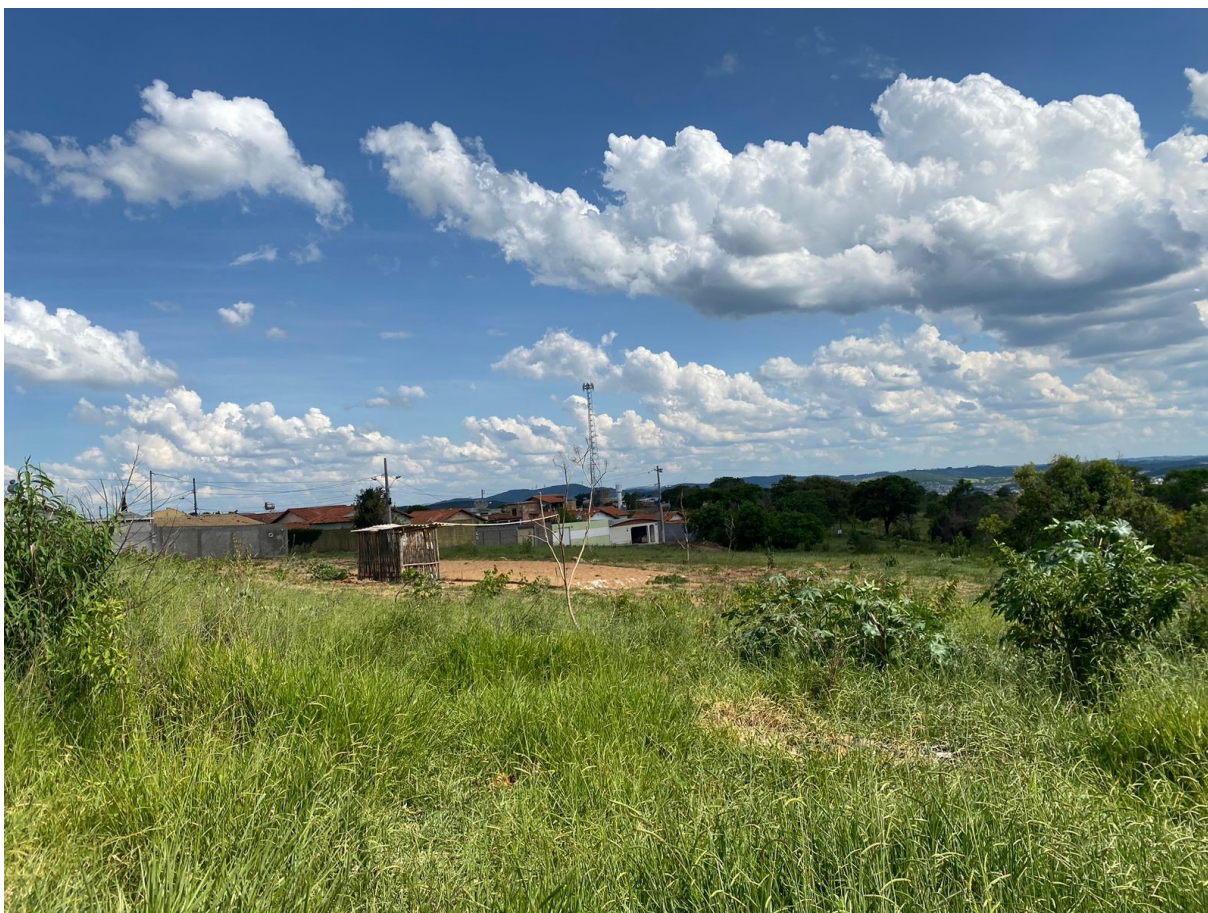
FOTO 06: Vista do terreno obtida pela Rua Cipó de São João, onde será edificado o projeto - Setor de Projetos Estruturais.
