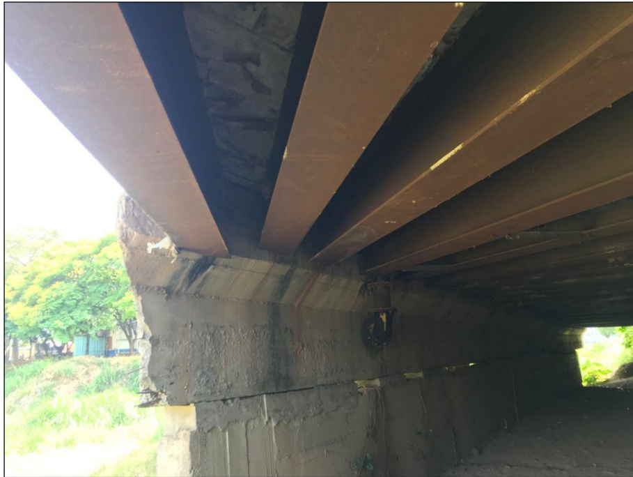
Figura 6. Pilar rotacionado.
