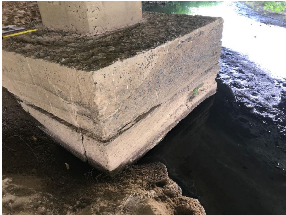
Figura 10. Bloco a proteger (esquerda) e bloco rotacionado.
