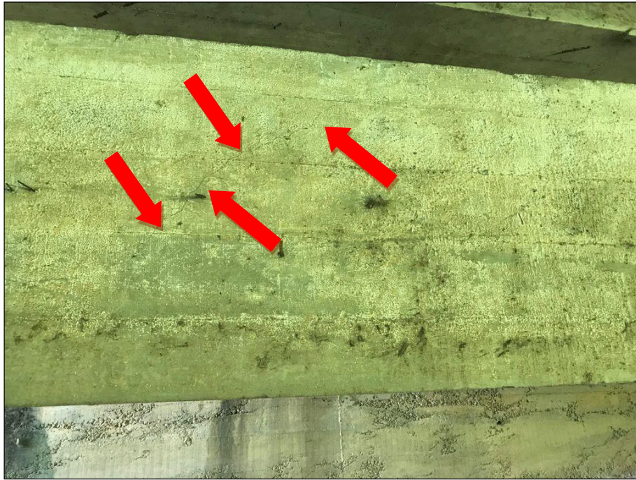
Figura 18 – Passeios estragados devido a movimentação da estrutura da ponte.
