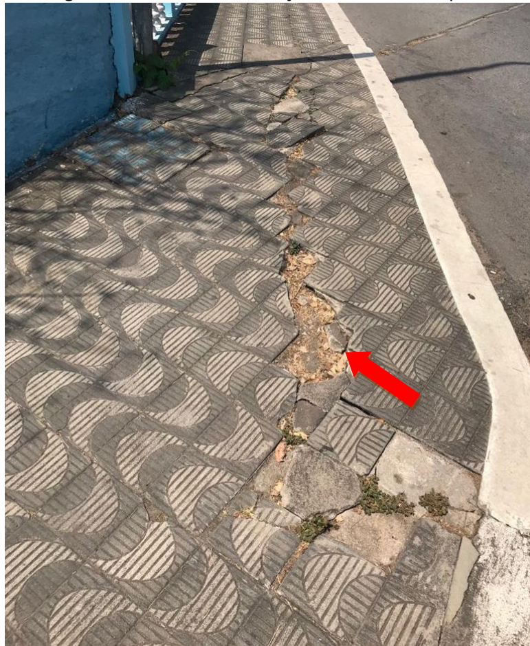
Figura 18 – Passeios estragados devido a movimentação da estrutura da ponte.
