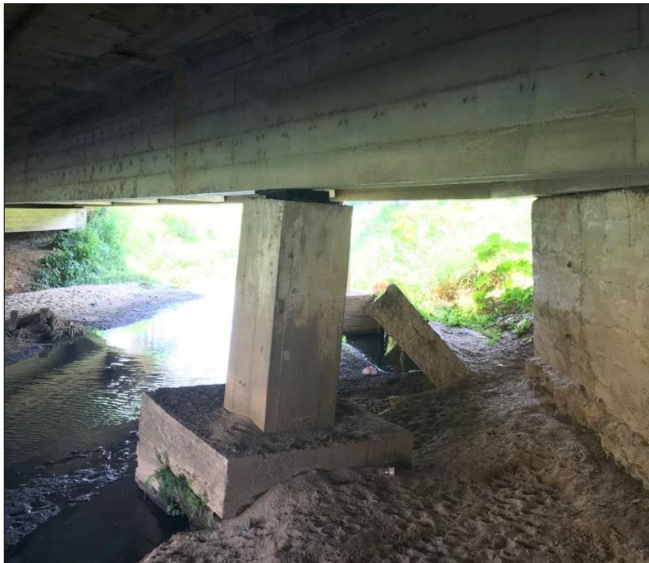
Figura 7. Movimento do Neoprene fretado e pilar rotacionado.
