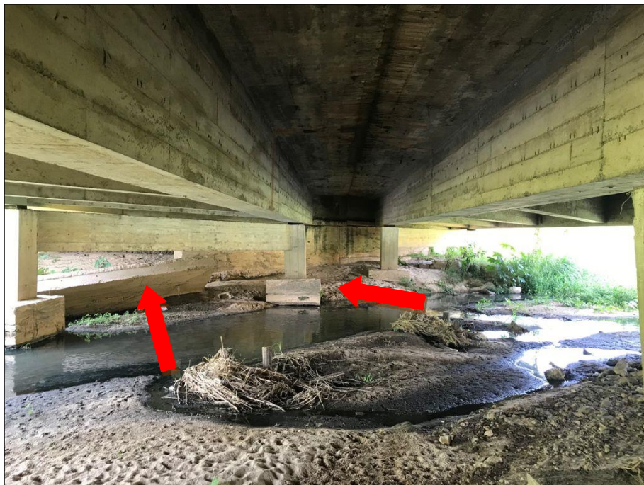
Figura 8. Muro caído e bloco rotacionado.
