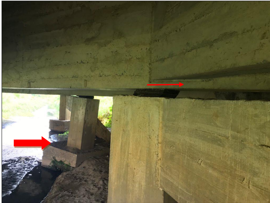
Figura 8. Muro caído e bloco rotacionado.
