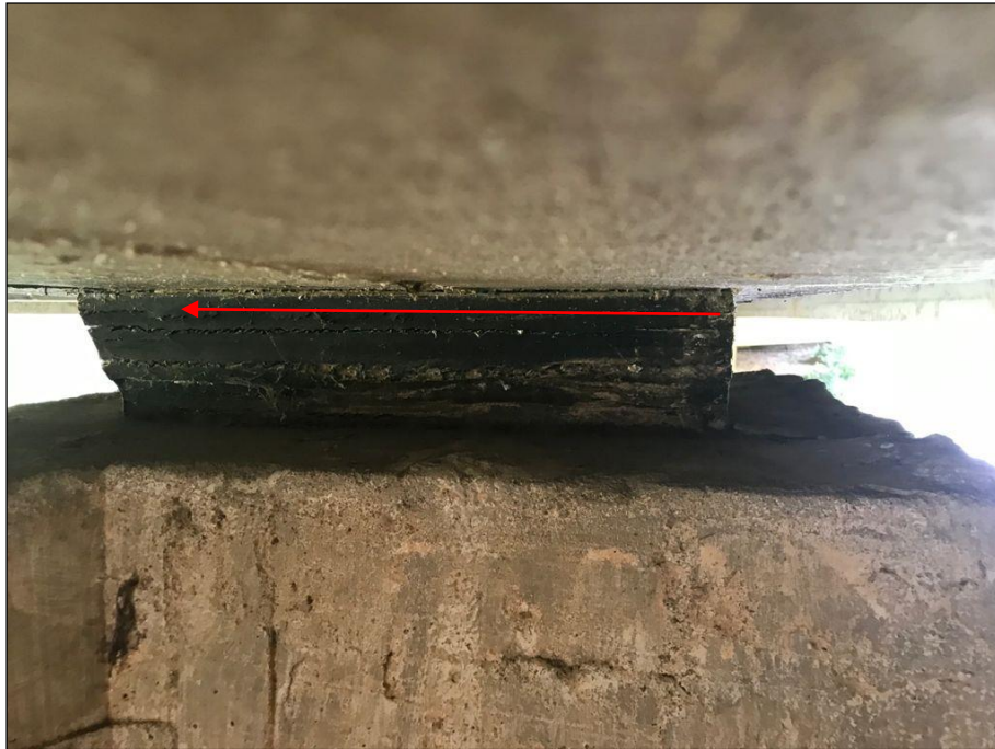
Figura 16 – Trinca de encontro na viga de travamento de topo dos pilares.
