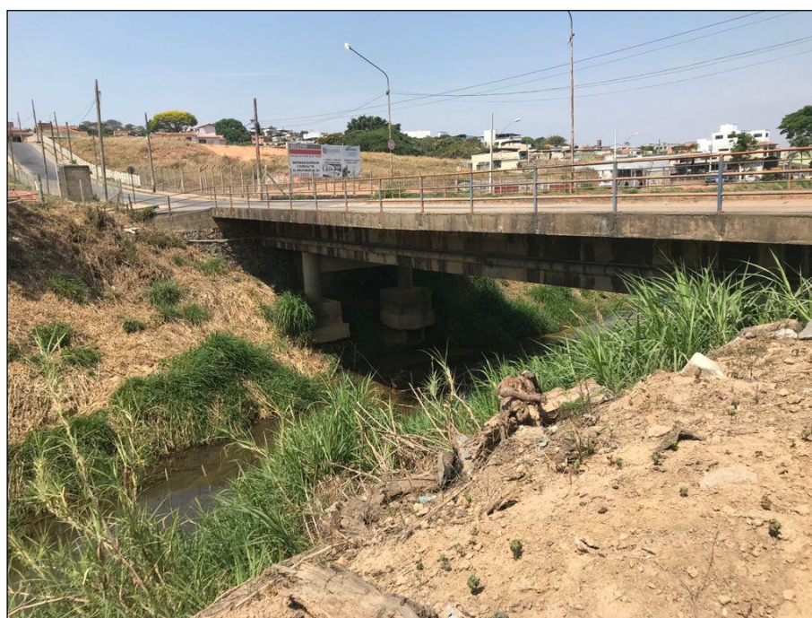
Figura 3. Vista da ponte na lateral inferior à jusante.
