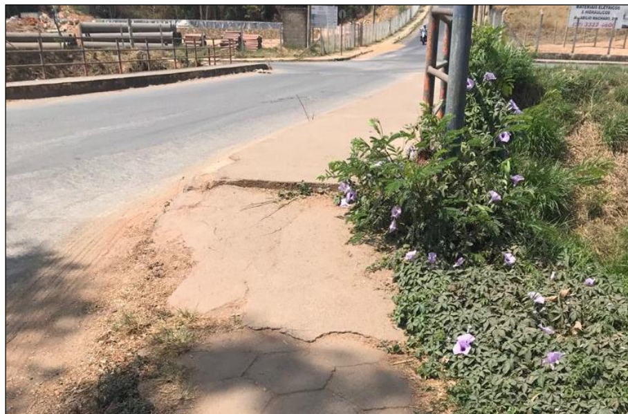
Figura 6. Sinais de escoamento de água e deterioração do concreto.
