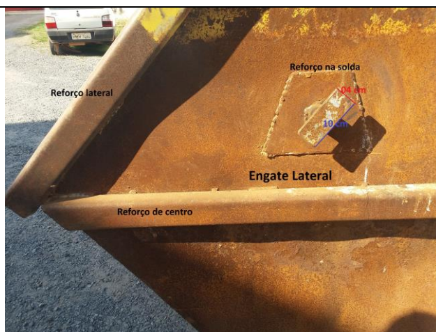
Foto 03: Reforços e engate lateral
